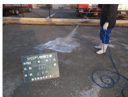
弊社モデルハウス建築前の防蟻薬剤散布の様子
