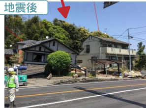
■熊本地震における木造住宅の建築時期別の損傷比率(建築学会によって実施された益城町中心部における悉皆調査より)
